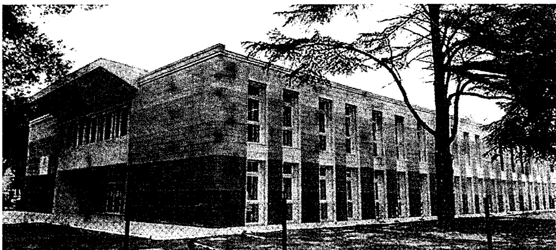
Rivestimento della facciata ventilata in gres porcellanato a manutenzione zero
